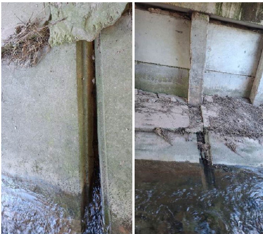
Pav. 11. Pasėdusio upės vagos dugno tvirtinimo plokštės
