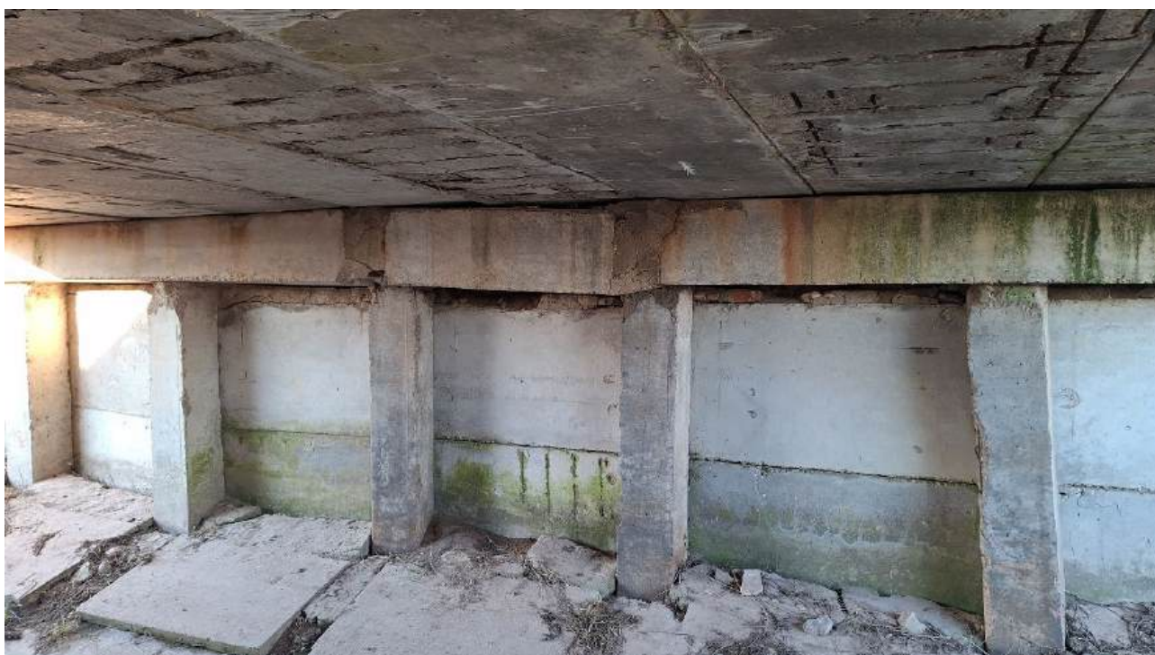
Pav. 7. Pažeidimai perdangos plokštėse
