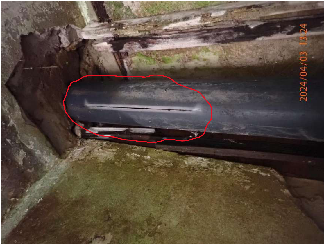
Nuotrauka Nr. 13. Lietaus nuvedimo sistemos PVC vamzdžiai sutruke, netinkami eksploatuoti.
