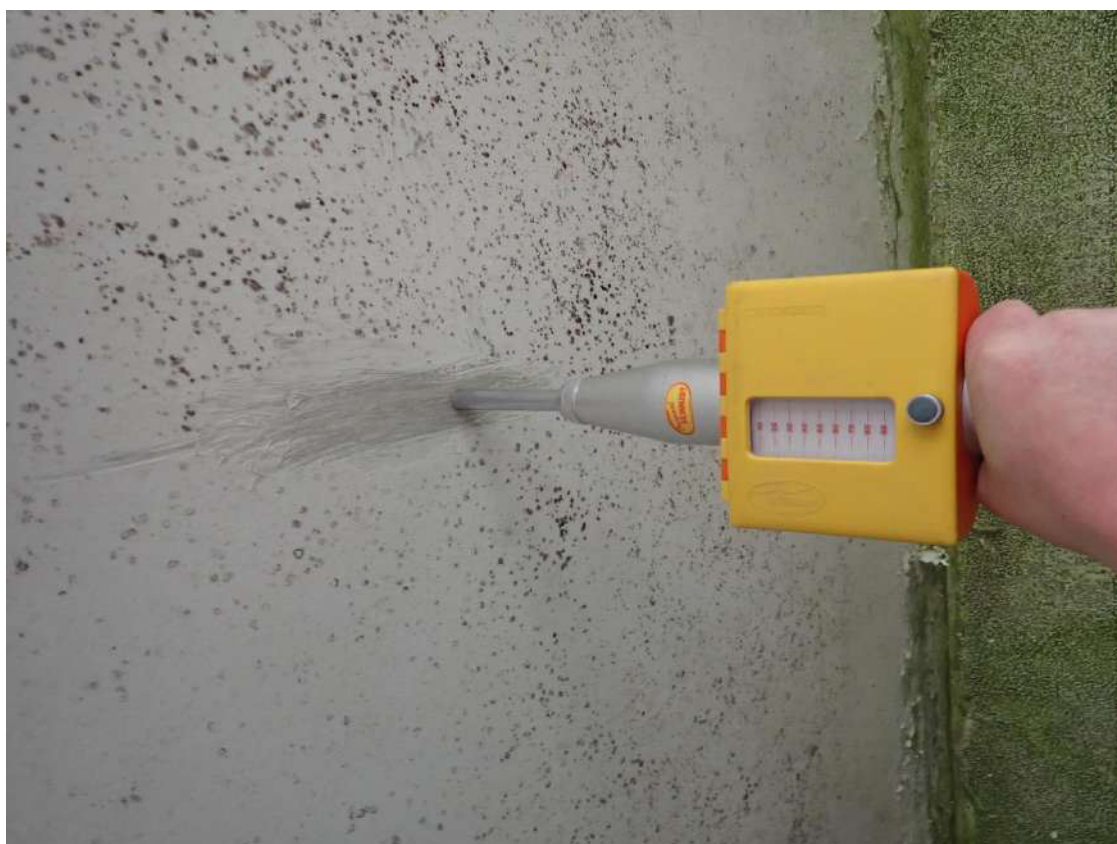
Nuotrauka Nr. 26. Perdangos plokštės betono stiprio nustatymas
