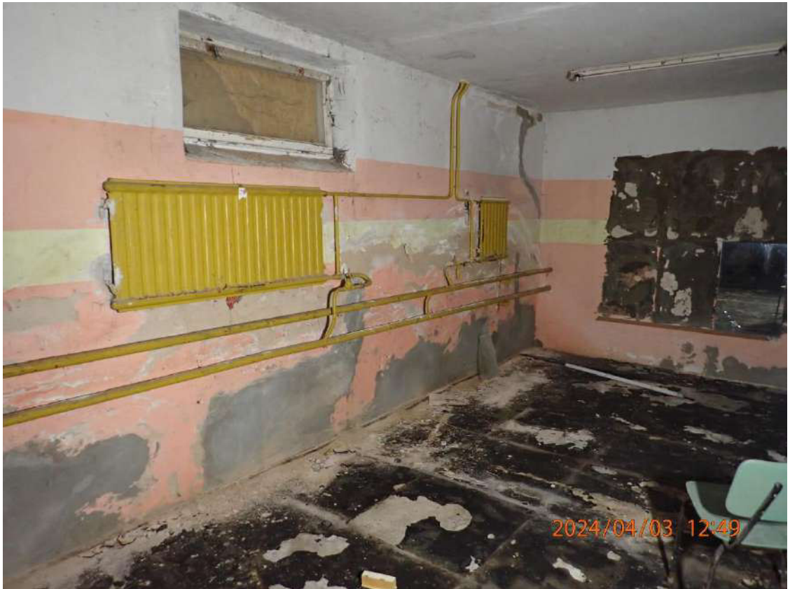
Nuotrauka Nr. 15. Šildymo sistemos radiatoriai ir vamzdynai surūdiję, vietomis vamzdžiai sutrūkinėję nuo peršalimo.
