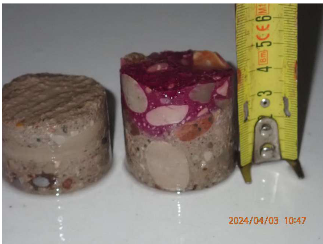
Nuotrauka Nr. 24. Denginio plokštės betono kernų (ėminių) tyrimų rezultatai
