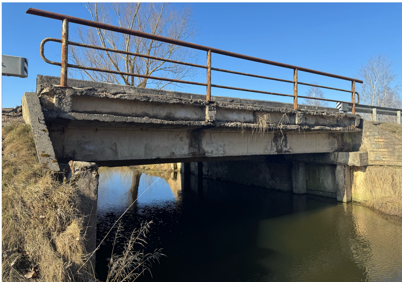
3 pav. Tilto fasadas
