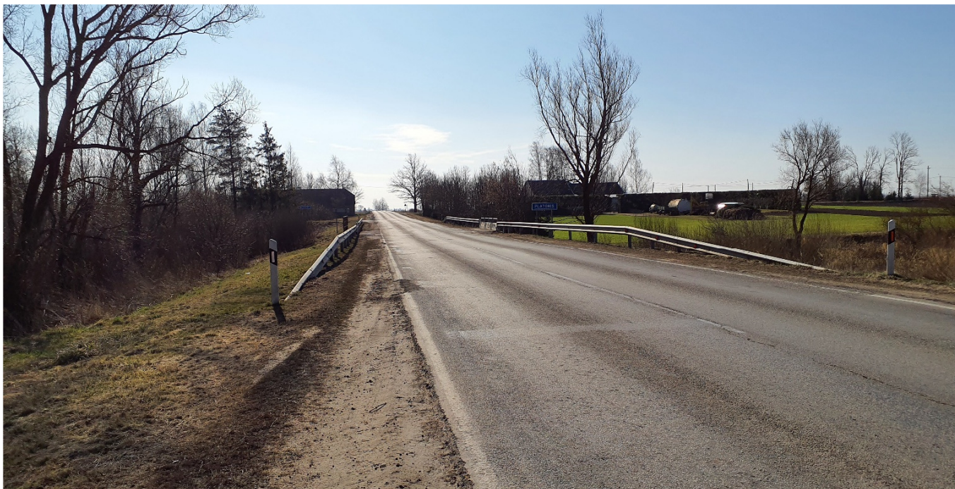
2 pav. Esama asfalto danga ties rekonstruojamu tiltu
