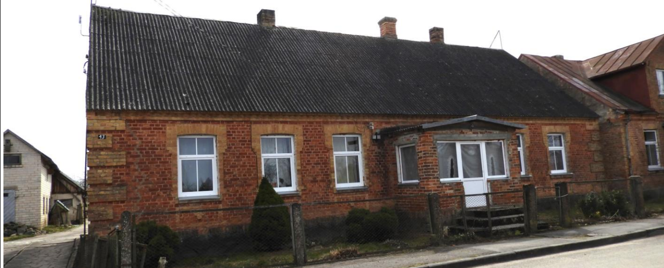
Nr. 11-3 Pavadinimas Pastatas, Kęstučio g. 43
