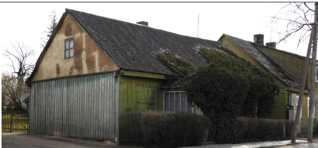
Nr. 11-2 Pavadinimas Pastatas, Kęstučio g. 15
