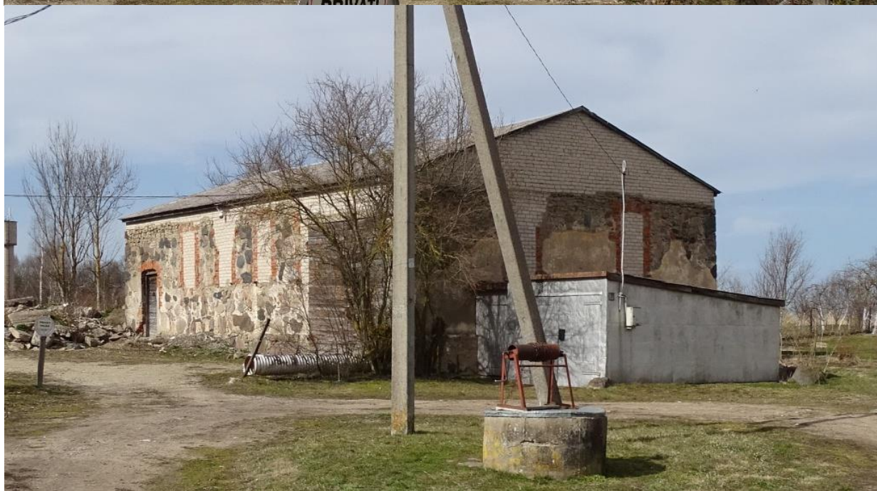
Nr. 16-1 Pavadinimas Pastatas, Gedimino g. Nr. 13a. Sinagogos liekanos
